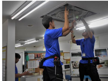
関東・甲信越ブロック会員事業所 エアコン清掃作業風景
